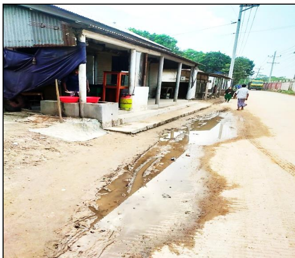
Drain-4, Kaliganj Pourashava
