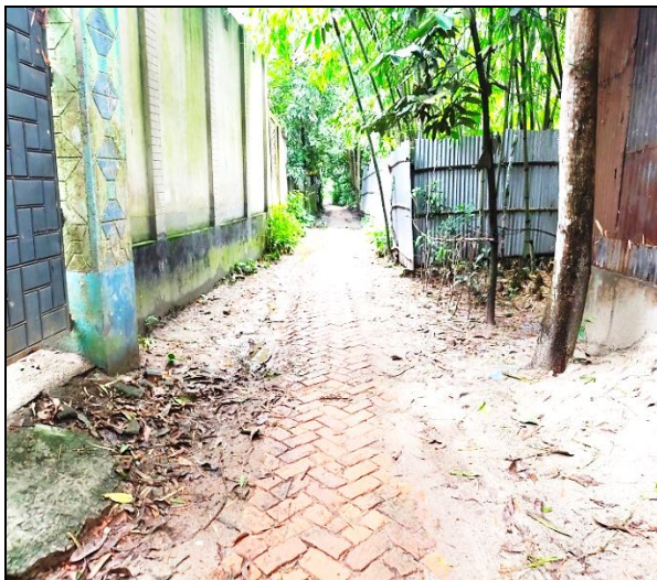
Road-8 Kaliganj Pourashava
