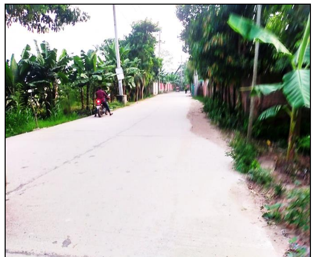
Drain-4, Kaliganj Pourashava
