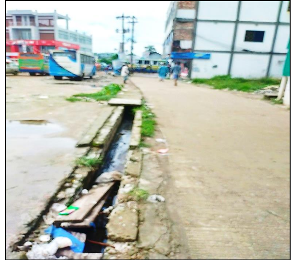
Drain-5, Kaliganj Pourashava
